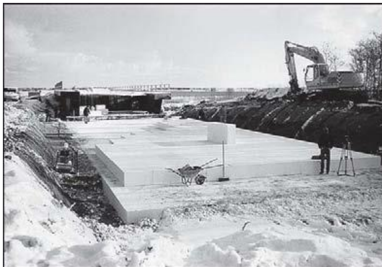
ภาพที่ 6 การก่อสร้างถนนด้วย EPS Blocks ในสหพันธ์สาธารณรัฐเยอรมนี ที่มา: กรมทางหลวงชนบท (2553)
