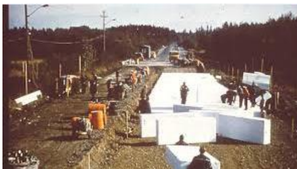
ภาพที่ 5 การก่อสร้างถนนด้วย EPS Blocks ในราชอาณาจักรนอร์เวย์
