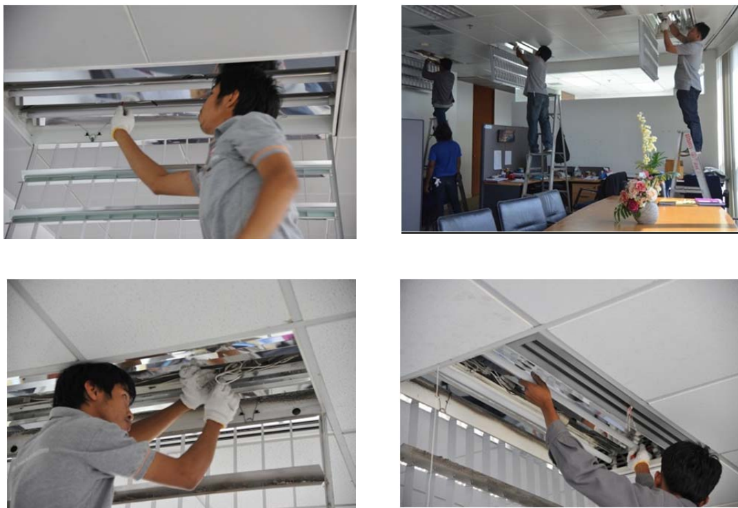
ภาพที่ 9 การติดตั้งหลอด LED
